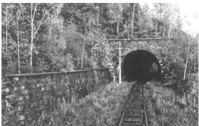
Вид на тоннель с култукской стороны.
