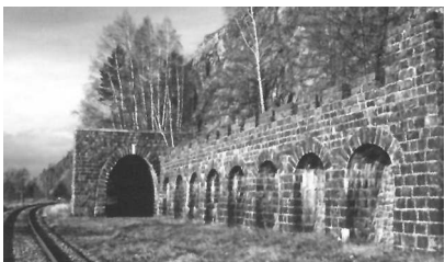
Каменная арочная подпорная стенка №8. Вид с иркутской стороны.
